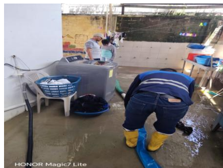
Trabajos de construcción del nuevo pozo séptico y canalización
