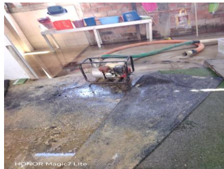
Bombeo de emergencia en el interior del centro – equipo motor y mangueras
