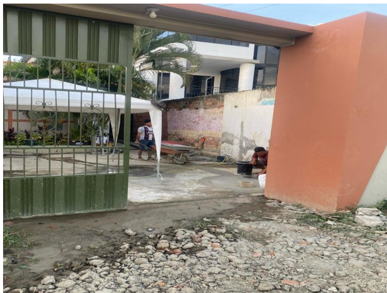
Casa Madriguera – vista exterior del centro con cartel identificativo durante las obras de rehabilitación
