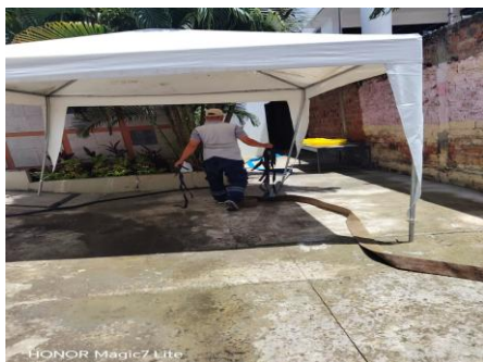
Patio interior del centro durante las labores de limpieza y achique
